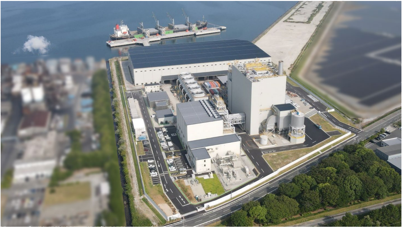
【本発電所の全景】
